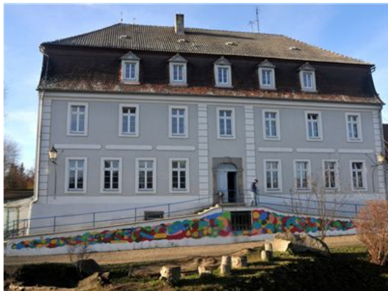
Laut Oberverwaltungsgericht Bautzen ist die Schkola in Ostritz nur eine Außenstelle von Ebersbach, weshalb die Oberschule keine staatlichen Zuschüsse erhält.
